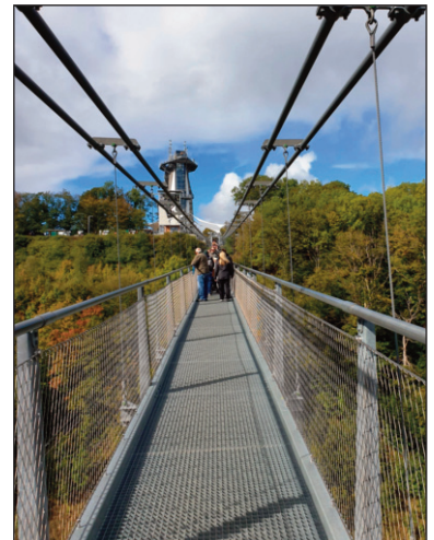
Für Schwindelfreie: Titan-Hängebrücke über die Bode.
