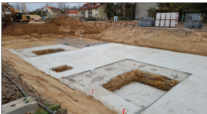
Fundamente für den 2. Bauabschnitt am Lichtenrader Bogen.
