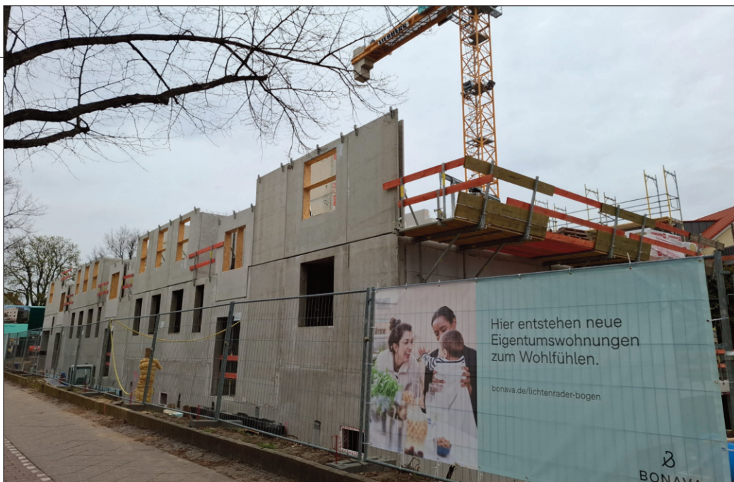
Der 1. Bauabschnitt mit 79 Eigentumswohnungen am Lichtenrader Bogen nimmt sichtbar Gestalt an.
